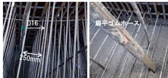
写真-4 配筋状況 (せん断補強筋)
