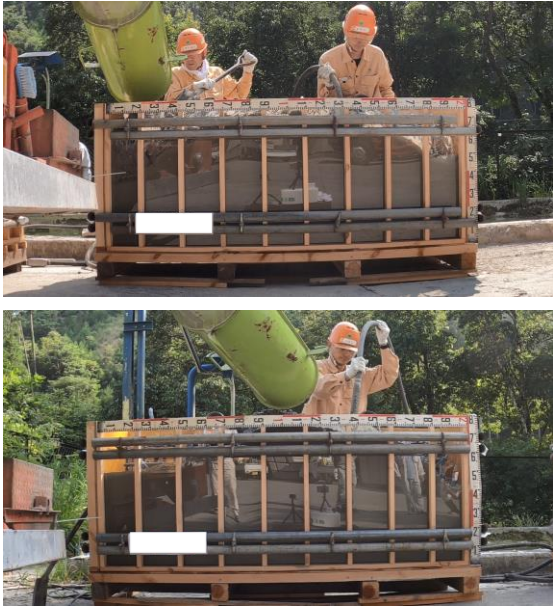
写真-2 施工状況 (上：ケース A, 下：ケース B)
