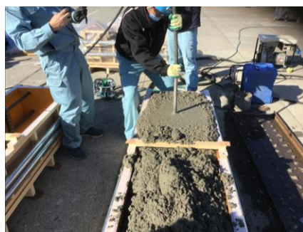
写真 2 打設・締固め状況
