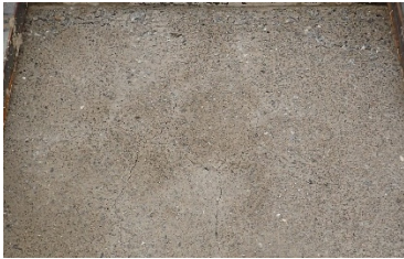
写真-2 レイトンス処理後の打継面
