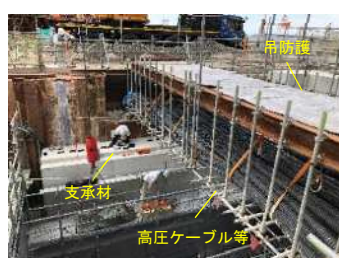
写真-7 支承材設置
