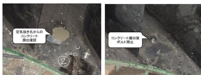
写真-2 空気抜き孔からの漏出、閉止状況
