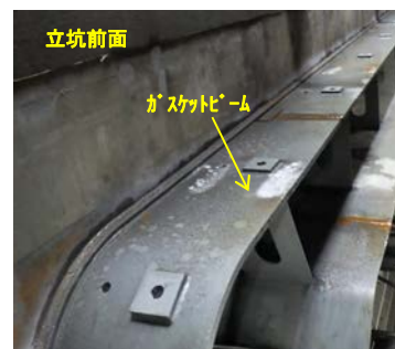
写真-2 ガasketビーム設置完了
