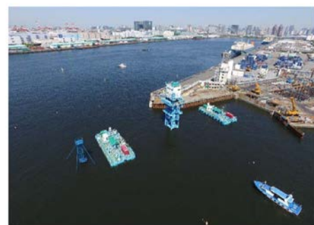
写真-3 沈埋函（7号函）沈設完了
