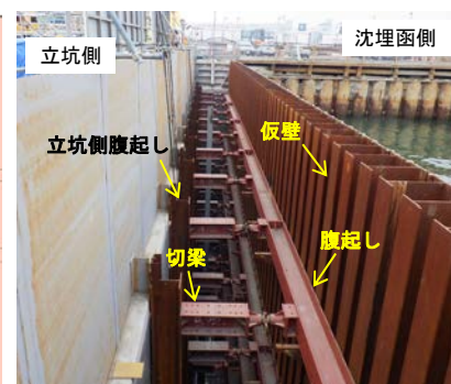
写真-1 仮壁配置状況
