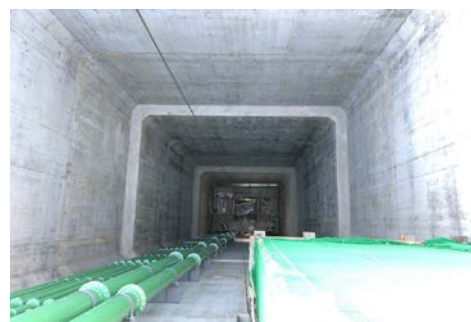
写真 7. 中間立坑施工完了 (2019 年 12 月)
