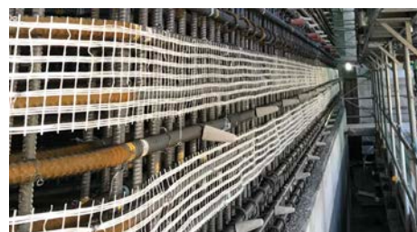
写真-5. ハイパーネット設置状況
