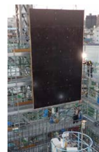
写真-1. 大型型枠設置状況
