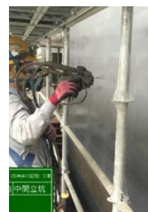
写真-2. 吹付外防水施工状況
