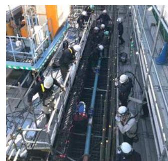
写真-3. 配管打設状況
