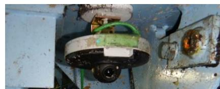
写真-6. LANを導入した遠隔操作用カメラ
