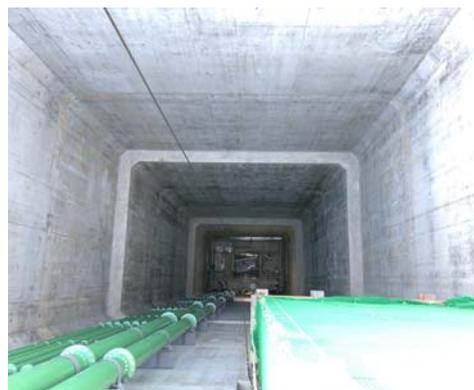
写真-7. 立坑構築完了全景
