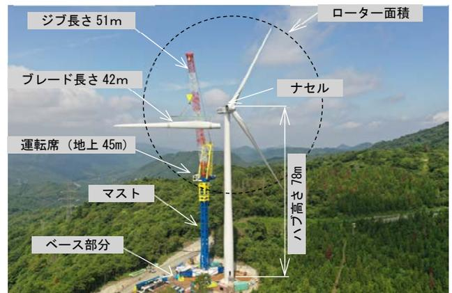
写真-1 タワークレーンによる2,000kW風車組立状況
