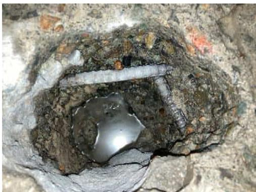
図-5 ウォータージェット削孔状況
