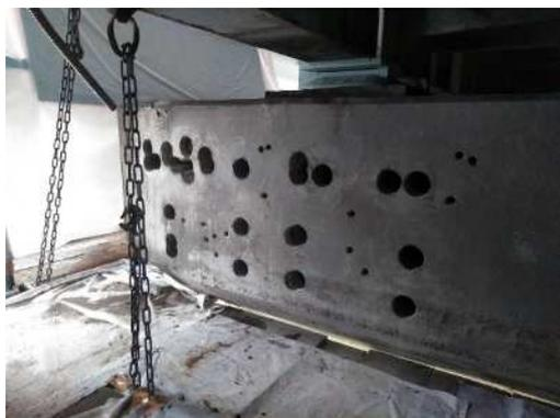
図-4 コアカッターによる削孔事例（別橋）
