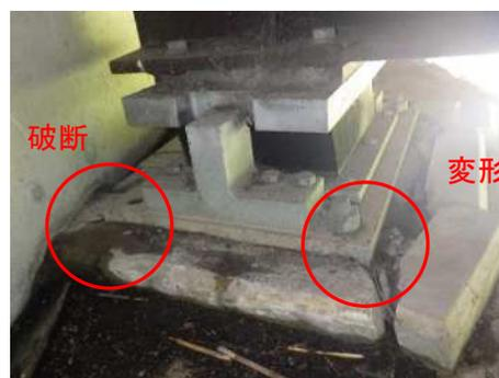
図-2 被災した支承（アンカー破断・変形）
