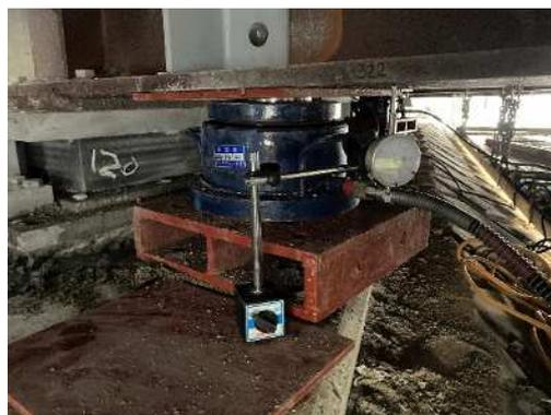
図-5 桁座での仮受状況
