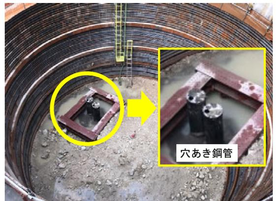
写真2 穴あき鋼管設置状況
