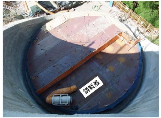
写真1 鋼製蓋による防護状況
