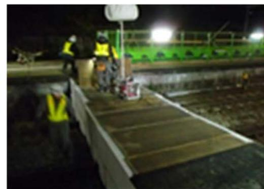
写真-5 EPS を利用した運搬路
