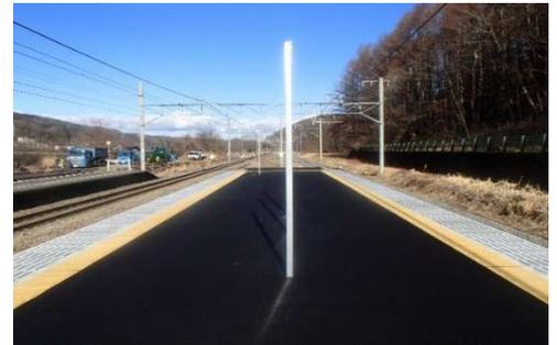
写真-1 ホーム扛上完了
