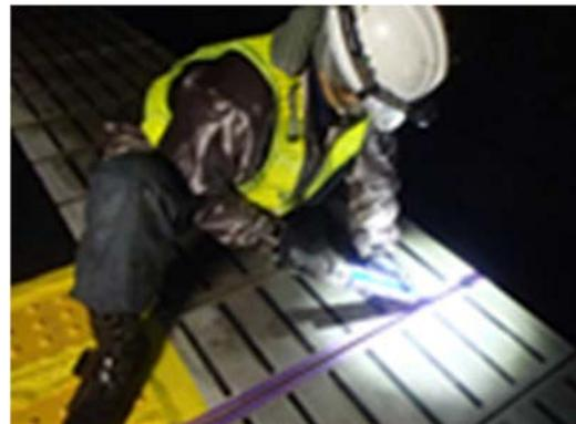
写真-4 目地への樹脂充填
