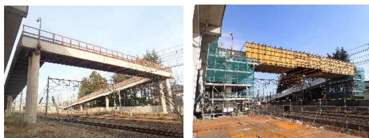
a) 吊り足場設置前
