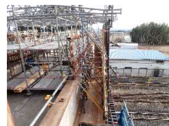
写真-4 足場固定状況
