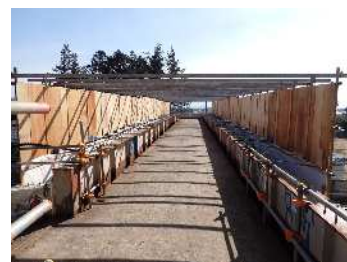
写真-6 吊り足場設置完了
