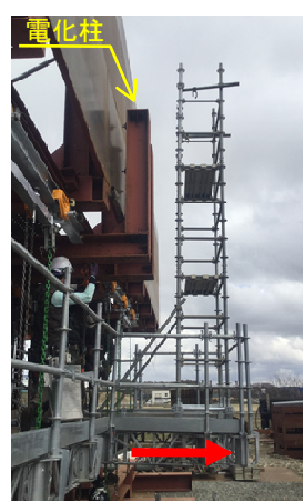
写真-5 移動完了全景
