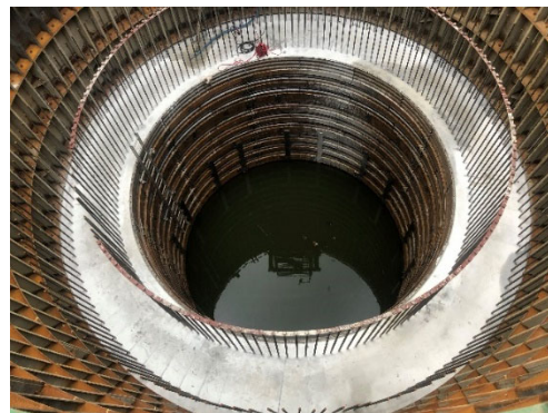
写真 3 基礎躯体側壁完了
