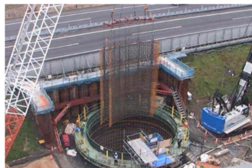
写真 1 ユニット鉄筋立坑内吊込状況
