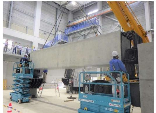
写真-1 縦梁架設状況
