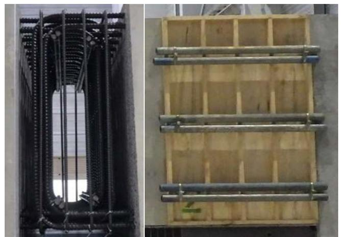
写真-3 接合部鉄筋・型枠組立状況
