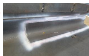
図-8 コーナー部L形鋼 取付状況
