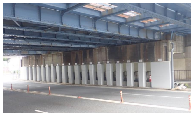
図-9 施工後全景写真
