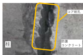
図-5 コア削孔状況
