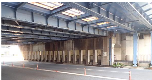
図-1 対象構造物起点方全景
