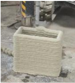
図-2 外枠製作状況
