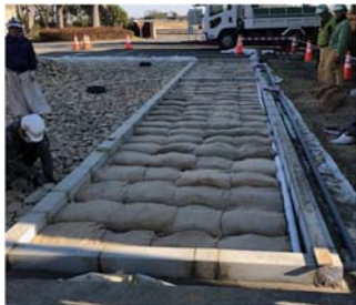
写真 1 土のうで舗装体の構築を試みた事例
