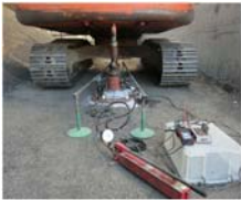
写真 4 平板載荷試験状況
