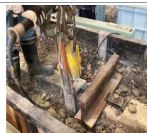
図 7 つき固め補修
