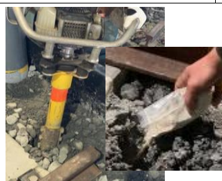
図 6 補修材を投入
