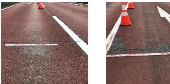
写真 1 すべり止め舗装の測定時の状況
