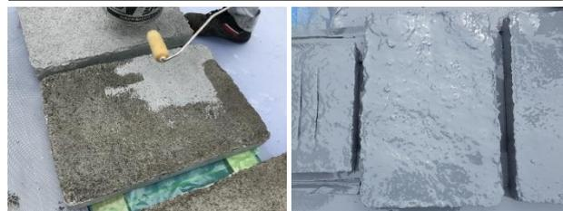
写真-3 プライマー塗布状況 写真-4 防水材塗布後状況
