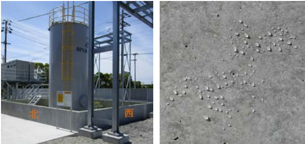
図 3 実構造物 図 4 撥水状況
