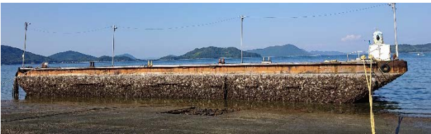
写真－1 PC バージ全景 (2020 年調査前撮影)
