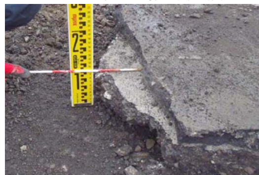
写真-1 表層に付着した固化したAs再生路盤 (舗設1年後)
