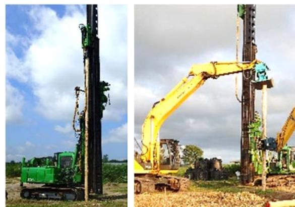
(a)静的圧入 (b)動的打設
