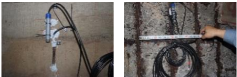
A 点(未処理部) B 点(はつり部)
