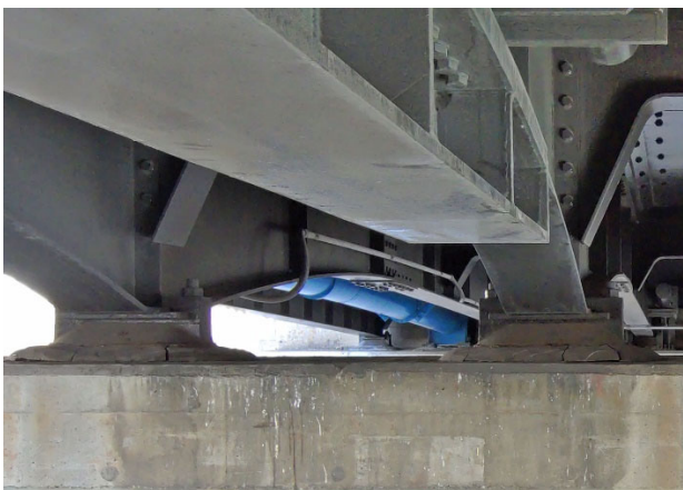
写真-6 支承部 (2021 年 3 月撮影)
