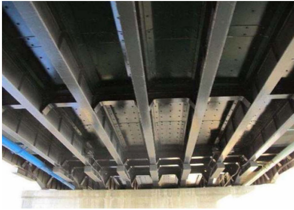
写真-3 上部構造主桁 (2014 年 11 月撮影)
