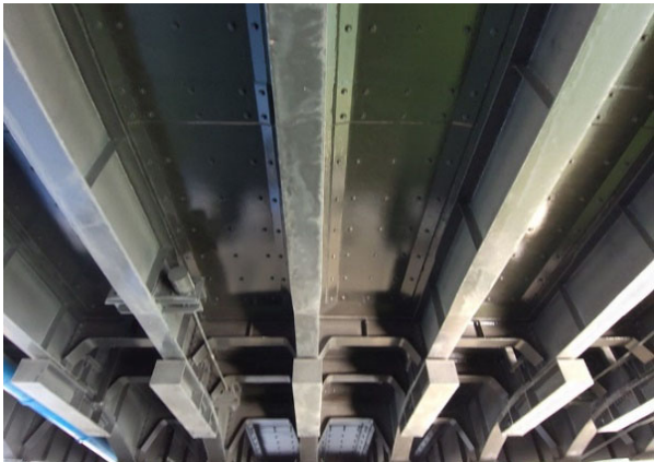
写真-4 上部構造主桁 (2021 年 3 月撮影)
