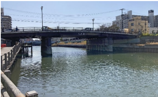
写真-1 対象橋梁
