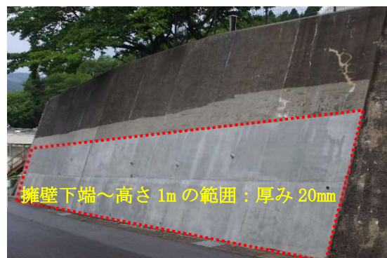
図-2 HPFRCC 薄層吹付け施工
