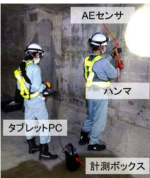
図-2 打音点検状況
