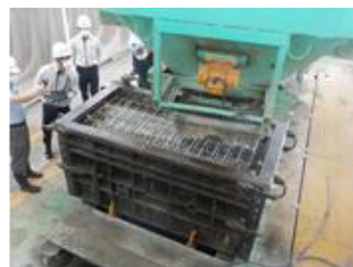
写真-1 打込み状況
