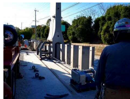
写真-3 横引き状況
