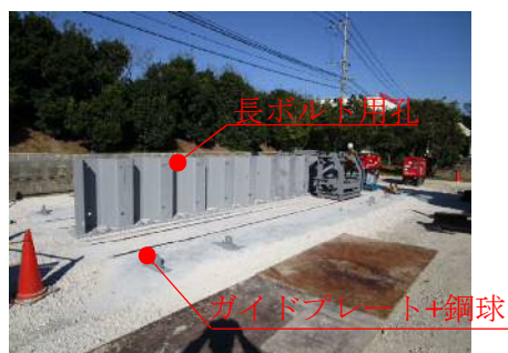
写真-1 鋼矢板の設置
