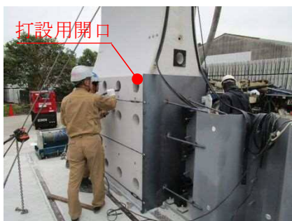
写真-5 間詰めコンクリート打設
