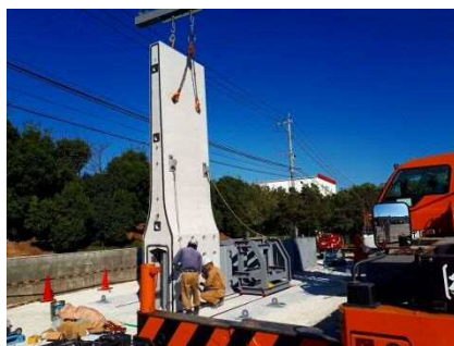
写真-2 プレキャスト防潮堤設置状況
