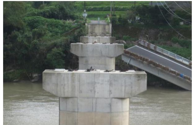
写真-3 橋脚上のアンカーボルトの様子
