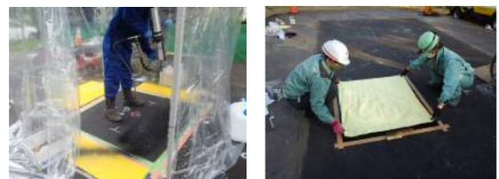
図-3 施工状況(左ポリウレア、右アラミド繊維シート)
