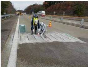
写真.3 バーステッチ工
