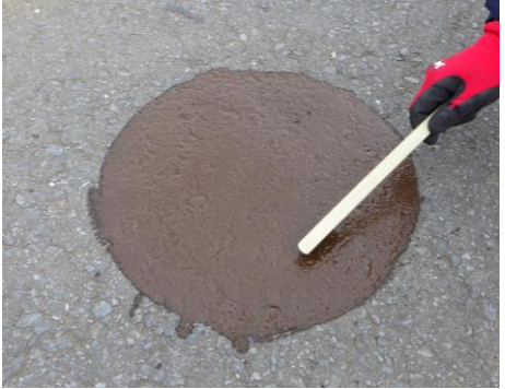
写真 2 乳剤パッチング状況
