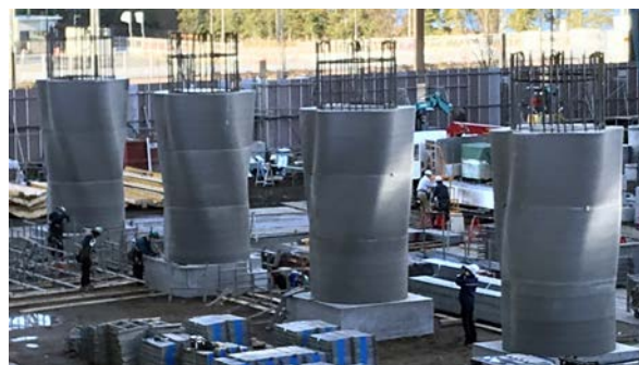
図-7 打設完了後の柱全景
