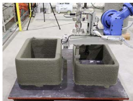
写真-1 3D プリンタによる積層状況
