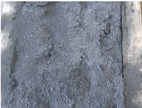
写真-1 吹付け後の仕上がり面
