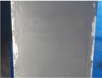
写真-2 選定した配合による吹付け後の仕上げ状況
