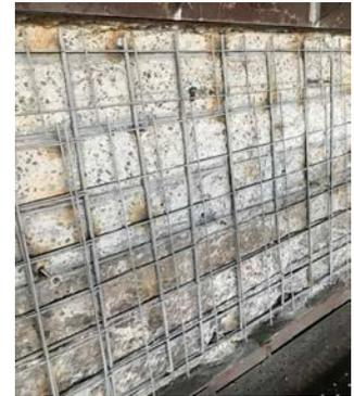
写真-1 鉄筋組立状況
