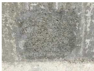
図-5 桁側面および切断面の研磨後の状況
