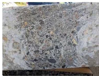
図-5 桁側面および切断面の研磨後の状況
