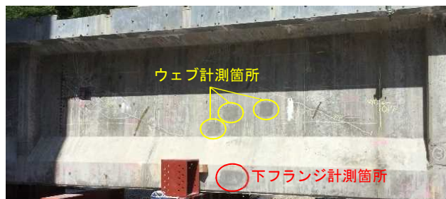
図-3 桁側面の計測箇所
