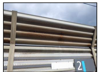
写真-1 溶融亜鉛めっき構造物腐食状況
