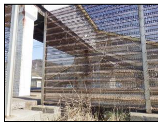
写真-1 溶融亜鉛めっき構造物腐食状況
