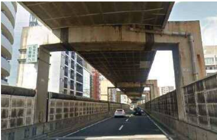
図-1 ダブルデッキ上層の橋脚横梁
