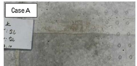
写真-4 打重ね線の微細ひび割れ
