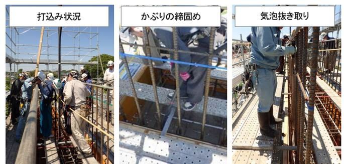
写真-2 コンクリートの施工状況
