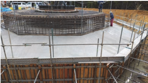
写真－1 施工翌日の仕上げ面の外観
