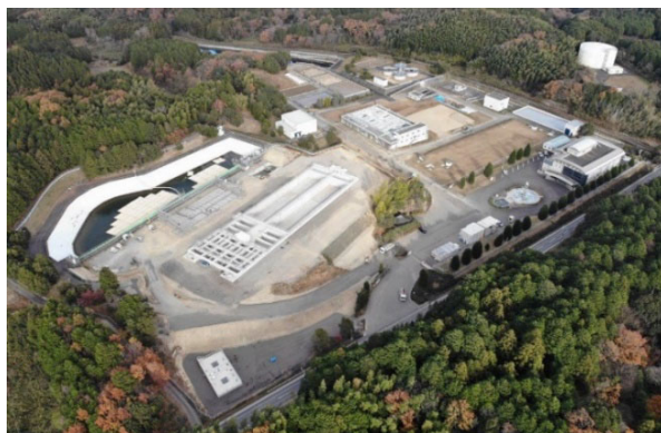
写真－1 凝集沈澱処理施設
