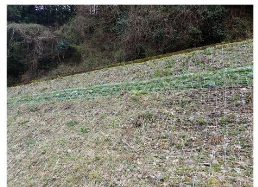
図－3 施工箇所写真
