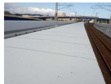
図5 防水工施工状況
