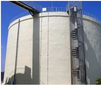
写真 4.1 A配水池全景
