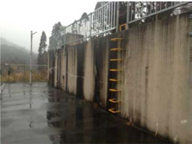
写真 4.2 B配水池全景
